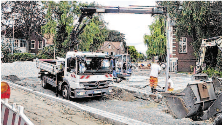
Die Bauarbeiten am Bummert gehen gut voran. Foto: Wolters
