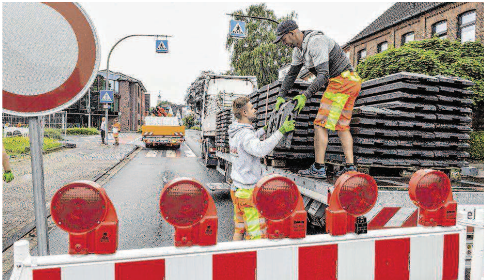
Am Mittwochvormittag wurden die Absperrungen am Bummert aufgebaut.
