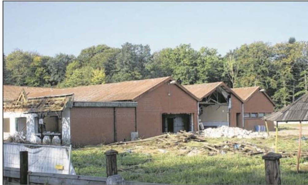
Auf dem Gelände wird ein Autohaus entstehen. BILD: HEYKES
