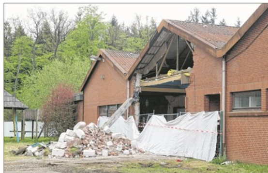
Die Gebäude sind zum Teil schon abgerissen wurden.
