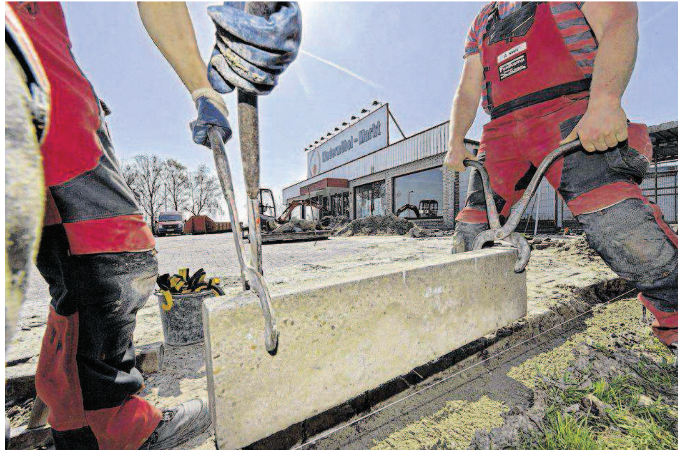
Beim ehemaligen Kindermöbelmarkt am Osseweg werden Vorbereitungen für den Ruma-Einzug getroffen.
