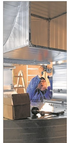
Die Lüftungsaggregate werden zusammengesetzt.
