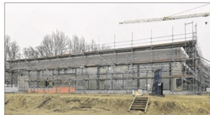
Ein Großteil der Fensterscheiben ist bereits eingesetzt worden.
