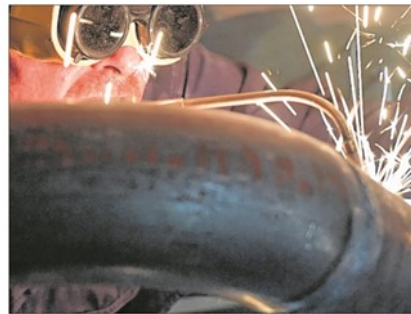
Im Keller wird geschweißt.
