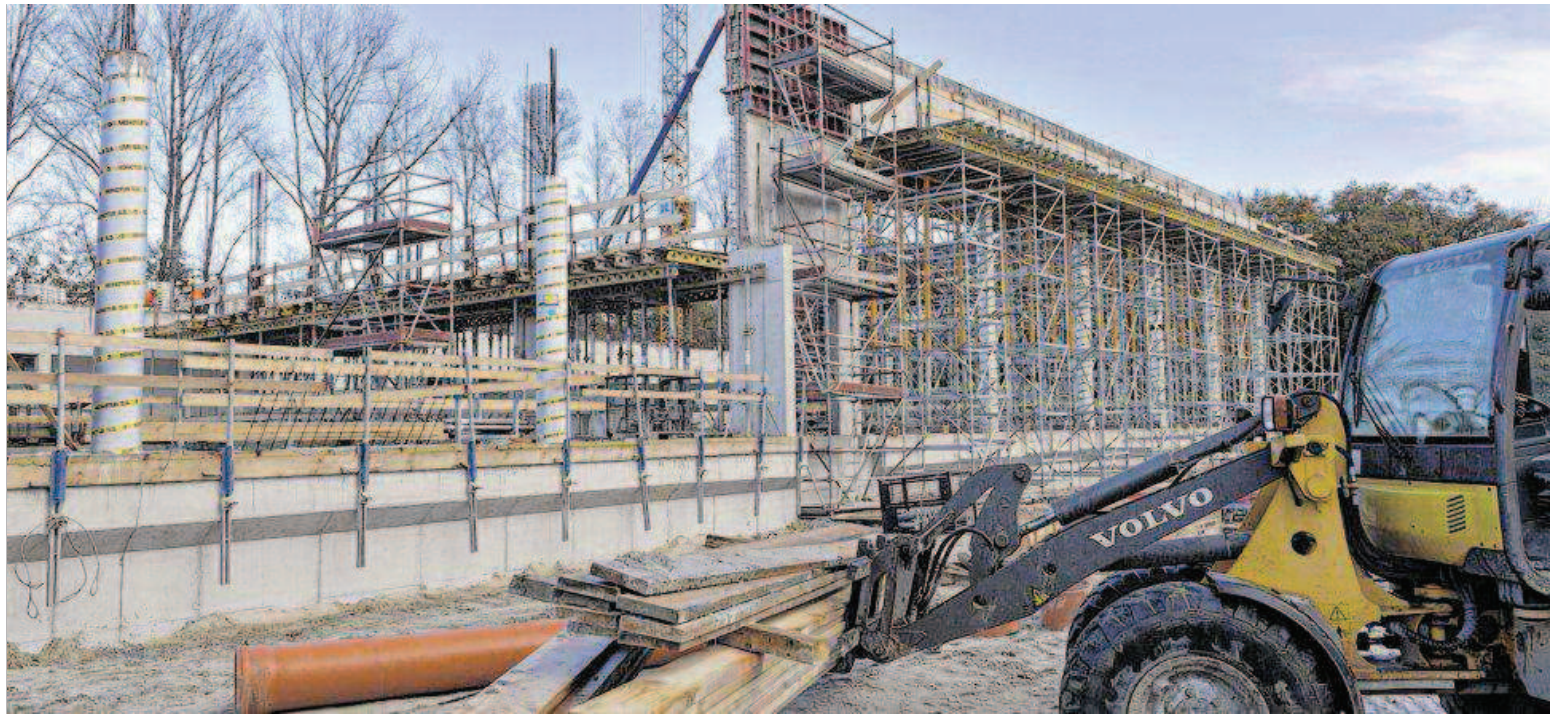
Die Arbeiten am Neubau des Leerer Hallenbads kamen bisher gut voran.
