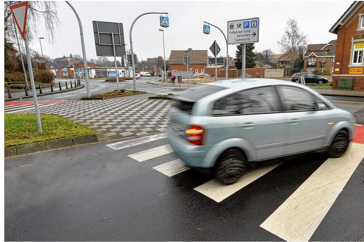
Gefahrenpunkt Bummert: Insgesamt 13 Unfälle ereigneten sich hier im vergangenen Jahr.
