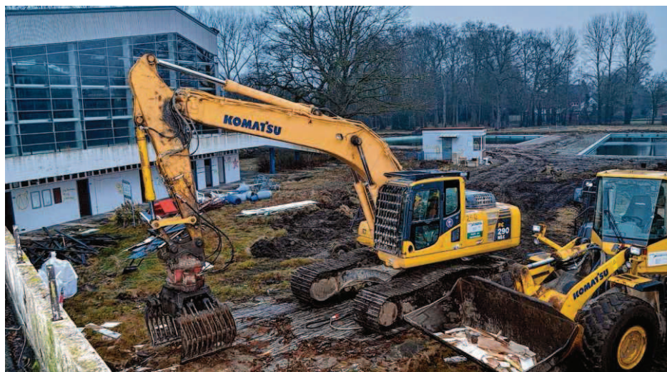
Auf dem Gelände ist der Oberboden bereits zum Teil abgetragen worden.
