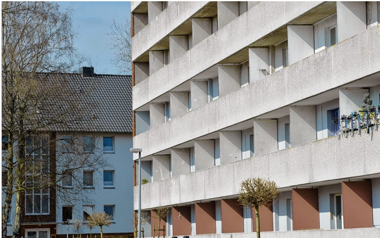
In der Weststadt soll in den Wohnungsbestand investiert werden. Auch der Abriss und Neubau von Häusern ist mit Hilfe von Fördermitteln eine Option.
