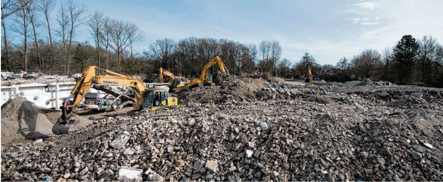
Das alte Hallenbad ist nur noch ein Haufen Schutt. Der hintere Teil des Geländes wird an das DRK verkauft.
