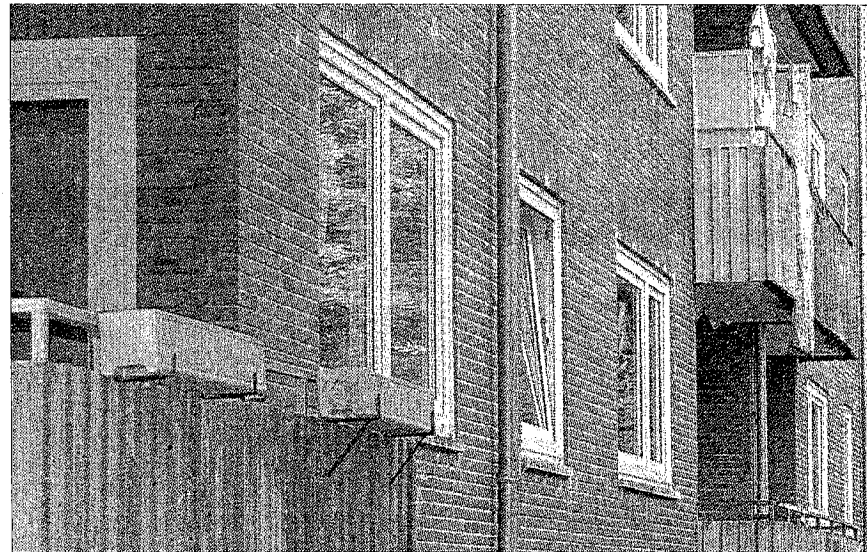
Auch die Mietwohnungen am Wendekamp in der „Weststadt“ von Leers könnten saniert werden. Bild: Schneider-Berents
